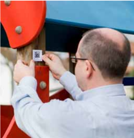
Die im Büro ausgedruckte Plakette mit dem Barcode wird am Gerät angebracht.
