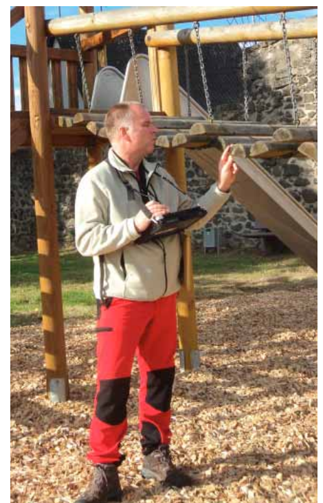
Bei der Sichtprüfung der Spielgeräte werden alle relevanten Daten mithilfe einer Kontroll-Checkliste am Tablett-PC schnell und rechtssicher erfasst.
